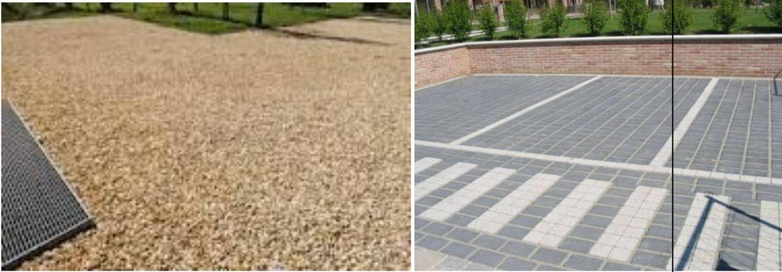
Le pavimentazioni permeabili, invece, sono costituite da materiali che non sono porosi, ma che creano un ingresso sulla superficie attraverso il quale l'acqua piovana penetra nella struttura sottostante. Un esempio sono i blocchi di calcestruzzo ed erba che formano una griglia di vuoti circondati da calcestruzzo compresso e offrono uno spazio di circa l'80% della superficie complessiva per far crescere l'erba e far infiltrare l'acqua.
