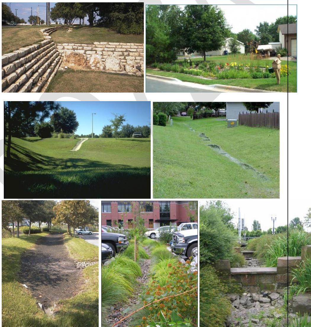
**Figura 20 – Esempi di strutture di laminazione fuori terra delle acque dei tetti, strutturabili sia per la sola laminazione sia per il riuso**
