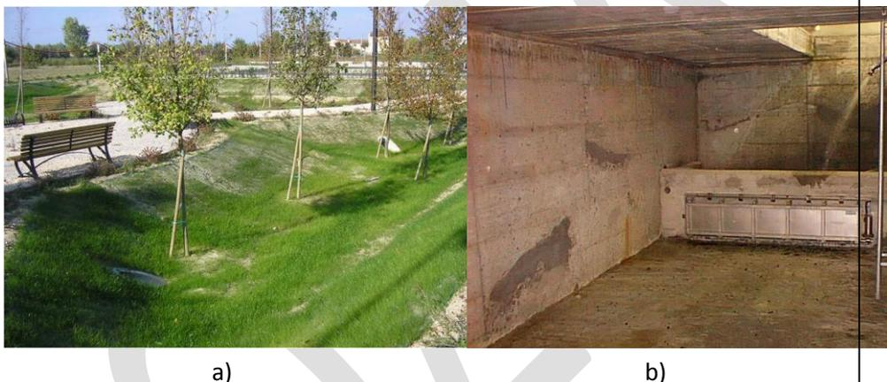
**Figura 42. Invasi di laminazione realizzati con interventi “verdi” (a) o con vasche chiuse in calcestruzzo (b).**
