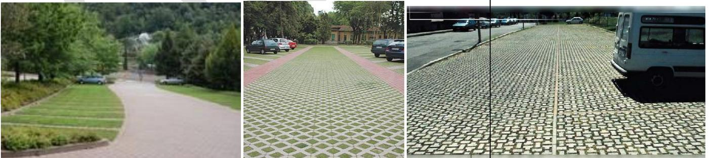
Le pavimentazioni permeabili potrebbero sostituire le tradizionali pavimentazioni nelle aree di parcheggio o nelle zone con traffico leggero, in quanto tali strutture presentano una scarsa resistenza meccanica. Il terreno dovrebbe essere pianeggiante o comunque con pendenze molto ridotte.
